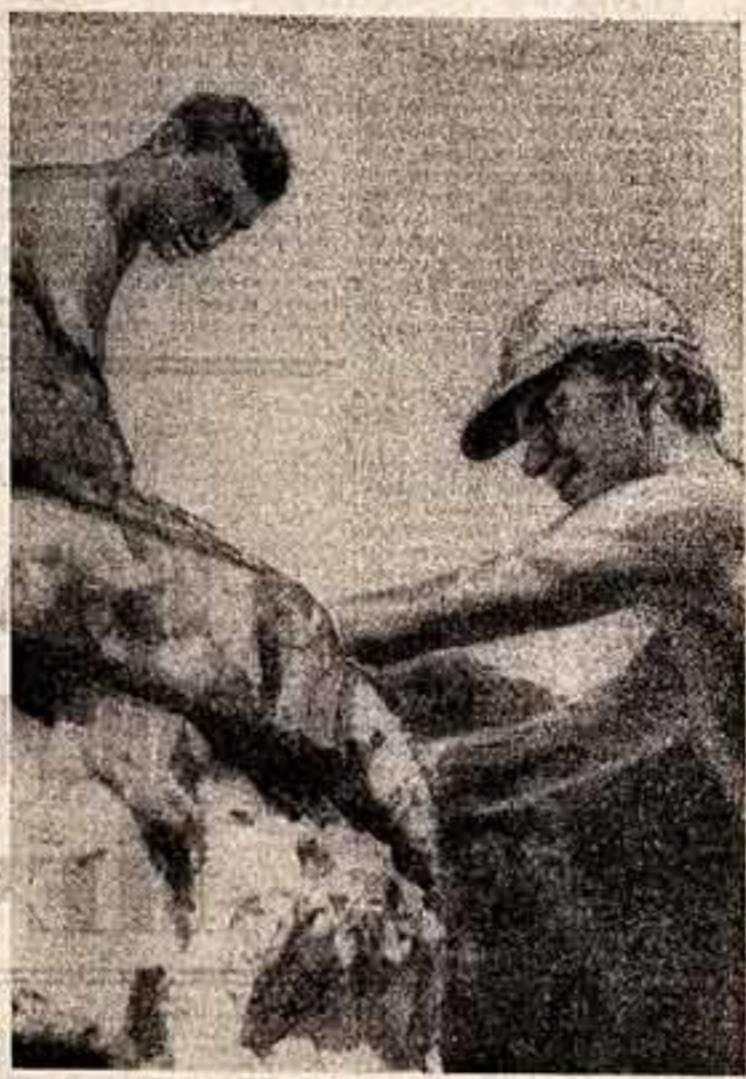
Студенты Московского архитектурного института В. Соколовский и Н. Качев на работах по реставрации Зеленодольского храма в селе Северный Намаз, Архыз. Лето 1968 г.
